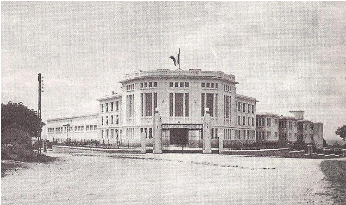
L'école Nationale de Coutellerie peu après sa construction
